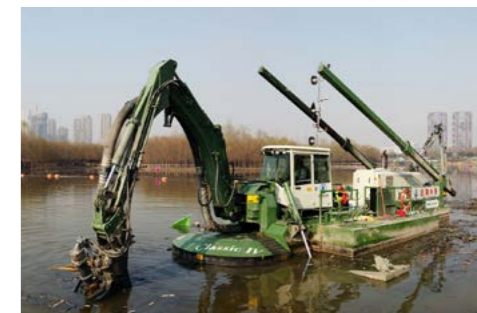
Extracción de lodo mediante dragado por succión
