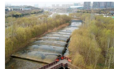
Deshidratación con tubos geotextiles
