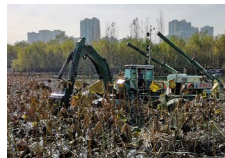
Eliminación de residuos y sedimentación mediante la excavación
