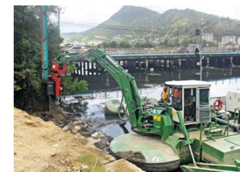
Protección contra la erosión de las riberas La Watermaster multipropósito se puede equipar con un hincador de pilotes vibratorio para instalar tablestaca con el fin de mejorar la seguridad y proteger contra la erosión.
