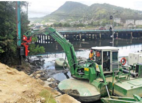
Protección contra la erosión de las riberas La Watermaster multipropósito se puede equipar con un hincador de pilotes vibratorio para instalar tablestaca con el fin de mejorar la seguridad y proteger contra la erosión.
